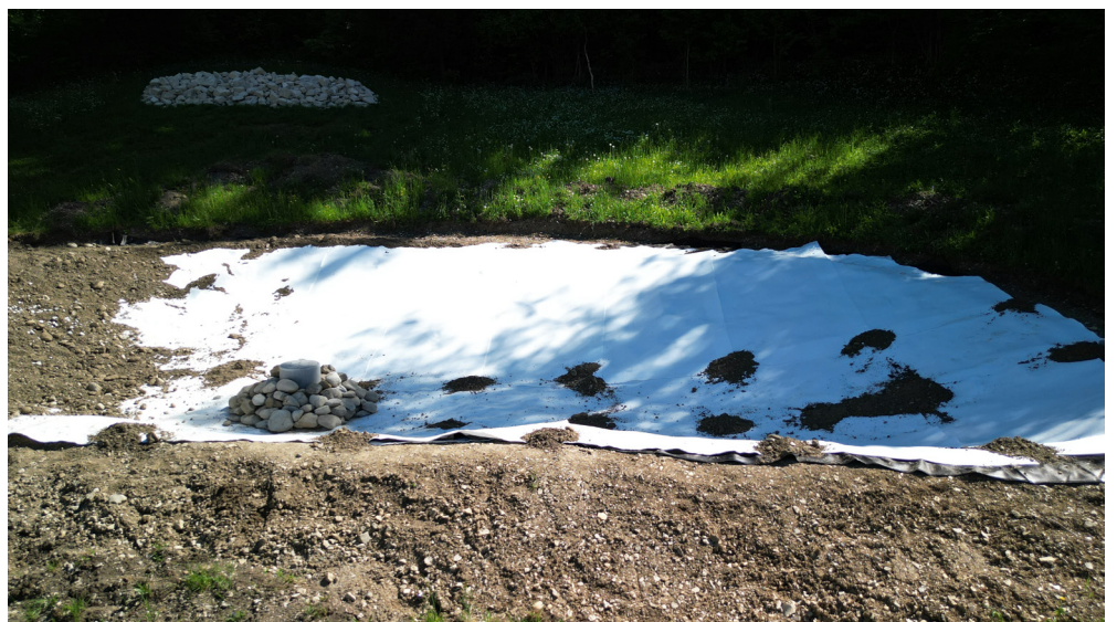
Während dem Bau ist das Schutzvlies noch gut sichtbar, bevor es von rund zwanzig Zentimeter Wandkies überschüttet wird. Unter dem Vlies dichtet eine Kautschukfolie das Biotop ab.
